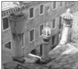
[56] Tre diverse tipologie di camino sullo stesso tetto.
