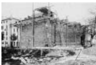
[225] La costruzione del padiglione delle Arti Decorative.
