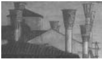
[58-59] Camini a campana decorati nel Miracolo al ponte di Rialto di Vittore Carpaccio, Venezia, Gallerie dell'Accademia. A destra, camino di Ca' Vendramin Calergi a tre canne fumarie.
