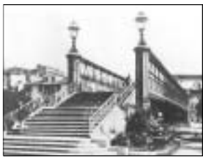
[111-112] Il ponte dell'Accademia realizzato in ghisa nel 1854 dalla fonderia Neville.
